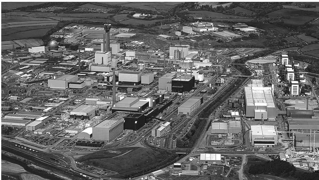
영국 컴브리아주에 해안가에 위치한 셀라필드 원자력 단지 전경
